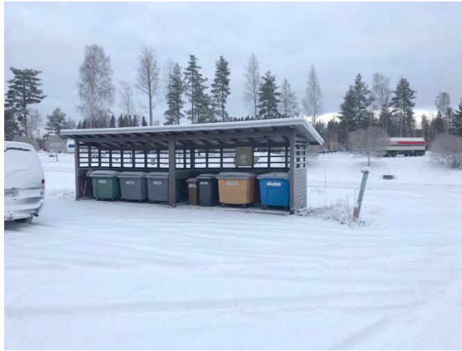
Kuva 10, alueen jätekatos on riittävän kokoinen
